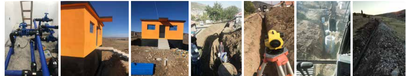
İÇME SUYU DEPOLAR (TAŞPINAR - EVCİ- YENİYAPAN - ÇARDAK - ABDURRAHMANLI)
